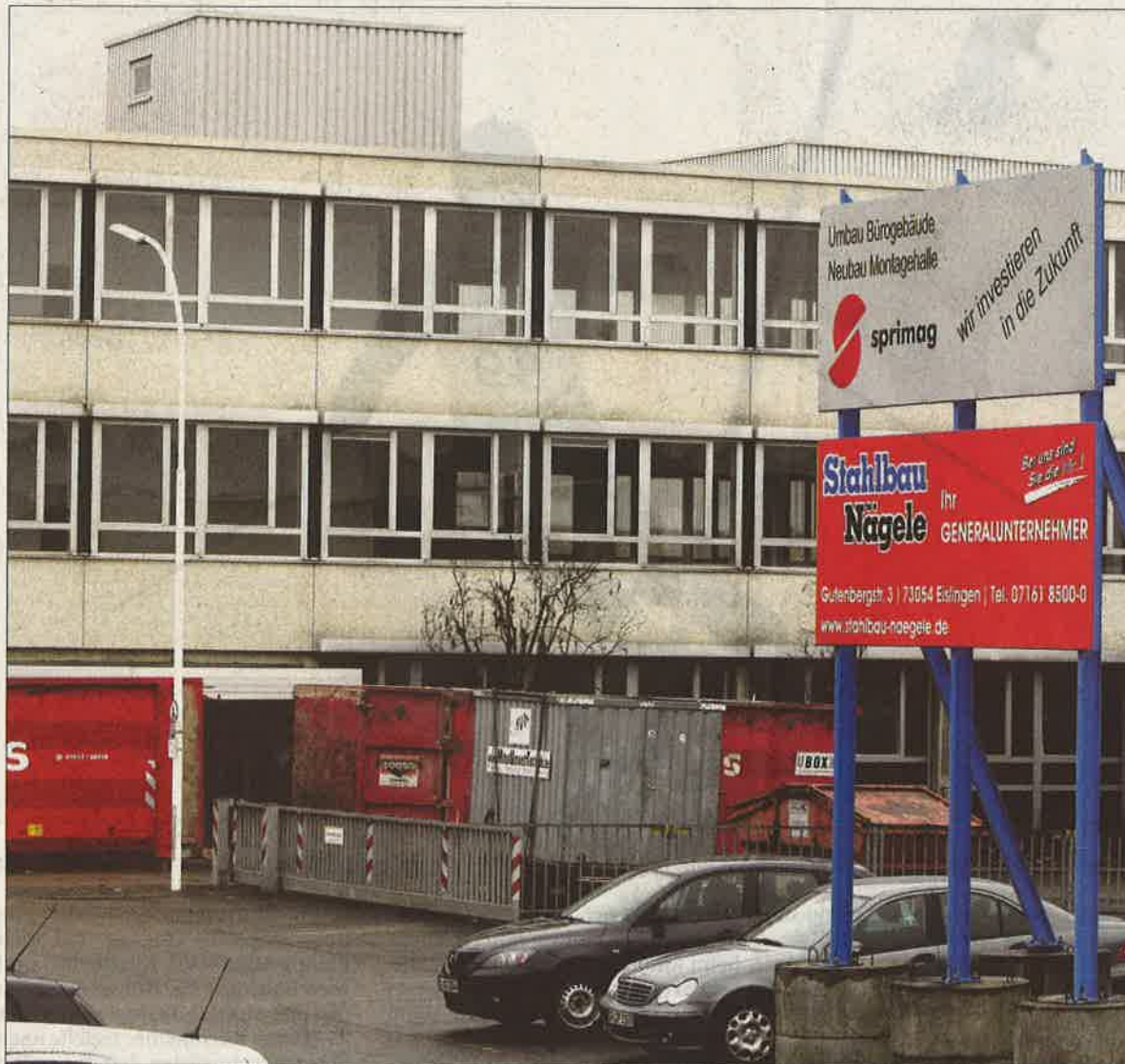
Auf dem Graupner-Areal baut Sprimag eine neue Montagehalle für Lackieranlagen.
